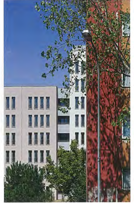
Sosyal konut blokları cephe ayrıntısı. Facade detail of social housing blocks.
