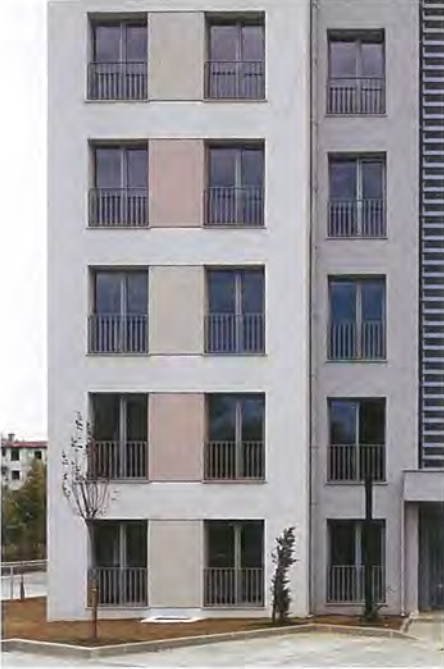
Lojman blokları cephe ayrıntısı. Facade detail of lodgment blocks.
