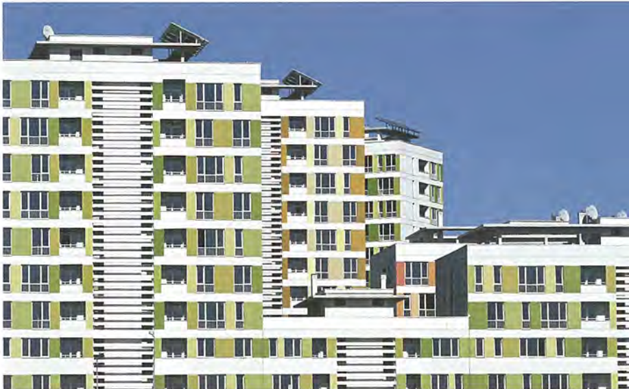
Ayrıntı (Uygulama süreci). Detail (Construction phase).
