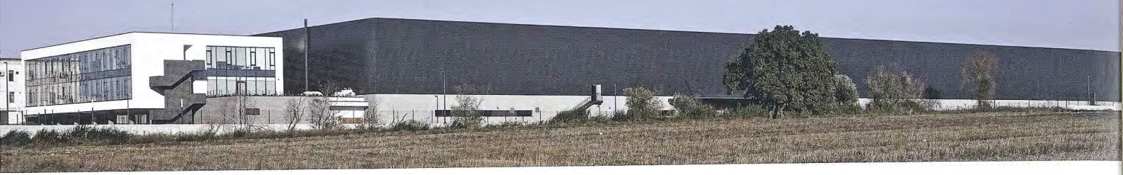
Tesis genel görünüm. General view of plant.
