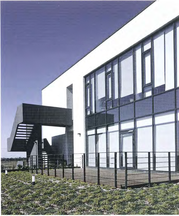
Çatı bahçesi. Roof garden.
