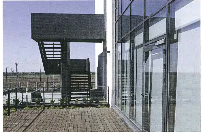
Çatı terası ve kaçış merdiveni. Roof terrace and fire escape.
