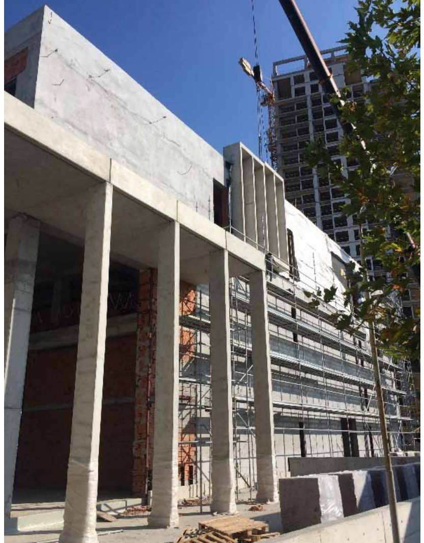
Prefabrik Elemanları Montajı
